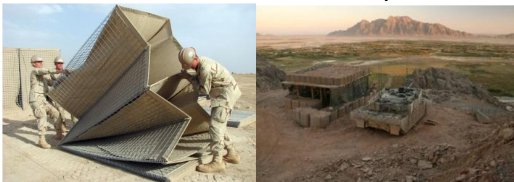
Рис.-1. Ручная сборка контейнера HESCO в боевых условиях.
