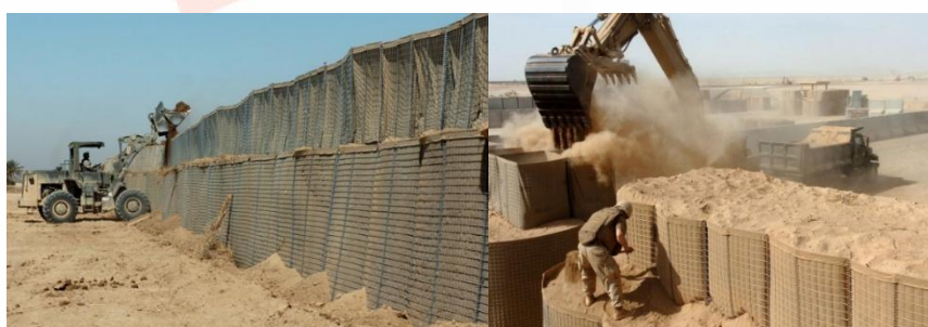
Рис.-2. Применение механизации при сборке контейнера HESCO в боевых условиях.
