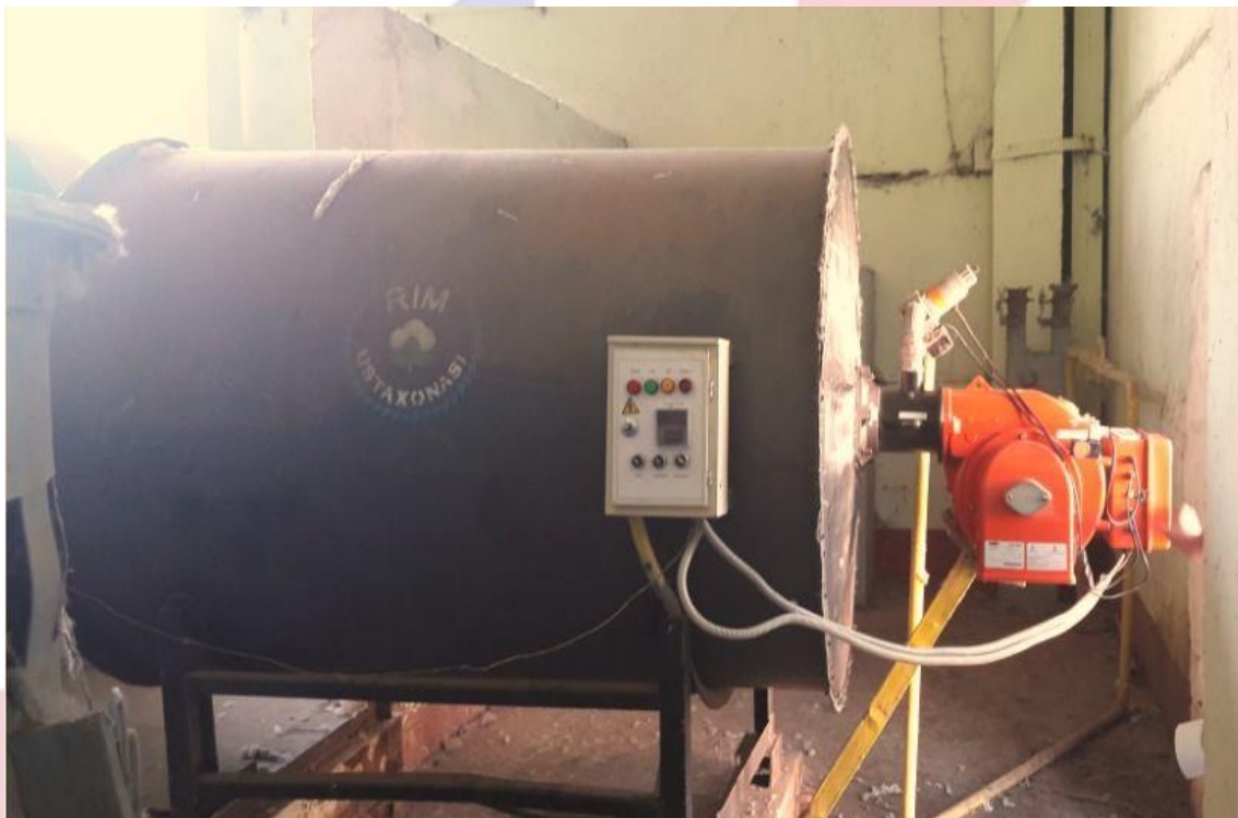
2-rasm. Avtomatlashtirilgan TGU issiqlik generatorining Bog‘dod tajriba-eksperimental paxta tozalash korxonasiga o‘rnatilgan nusxasi
